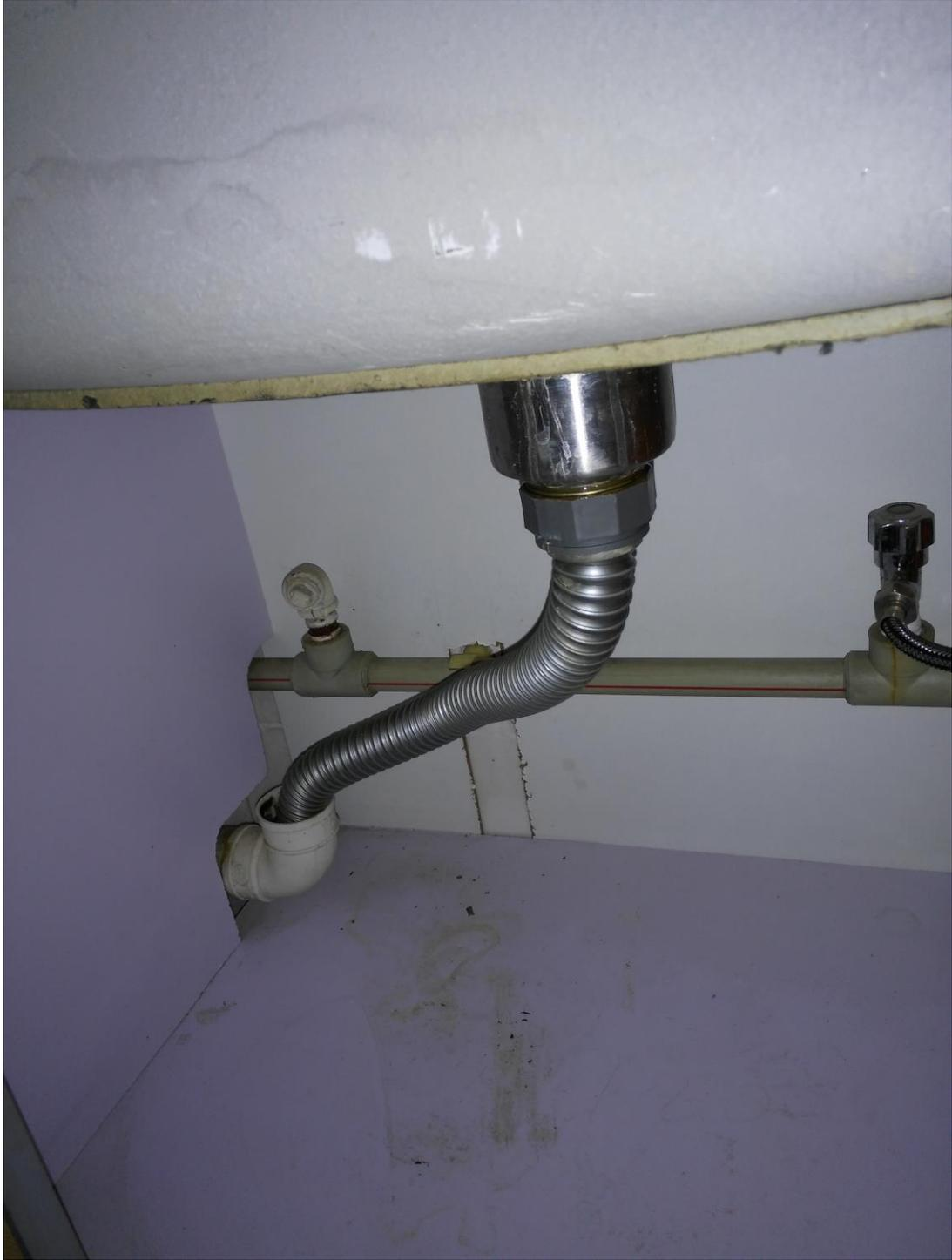
图 3 厨房软管接头没有水弯头且排水管没有密封
