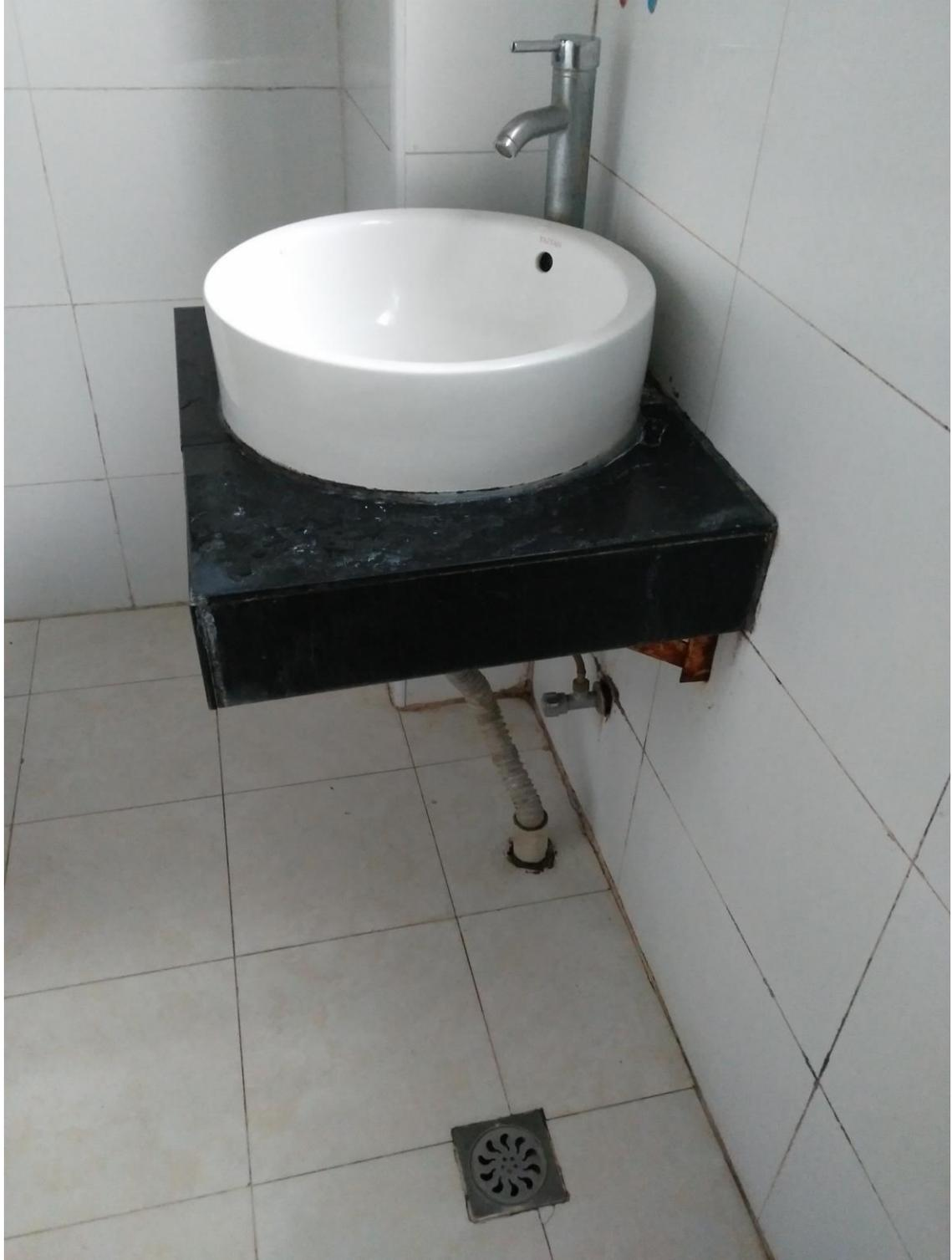
图 1 中国浴室中常见问题：水槽下面没有安装水弯头；下水管线没有密封；地板地漏没有弯头
