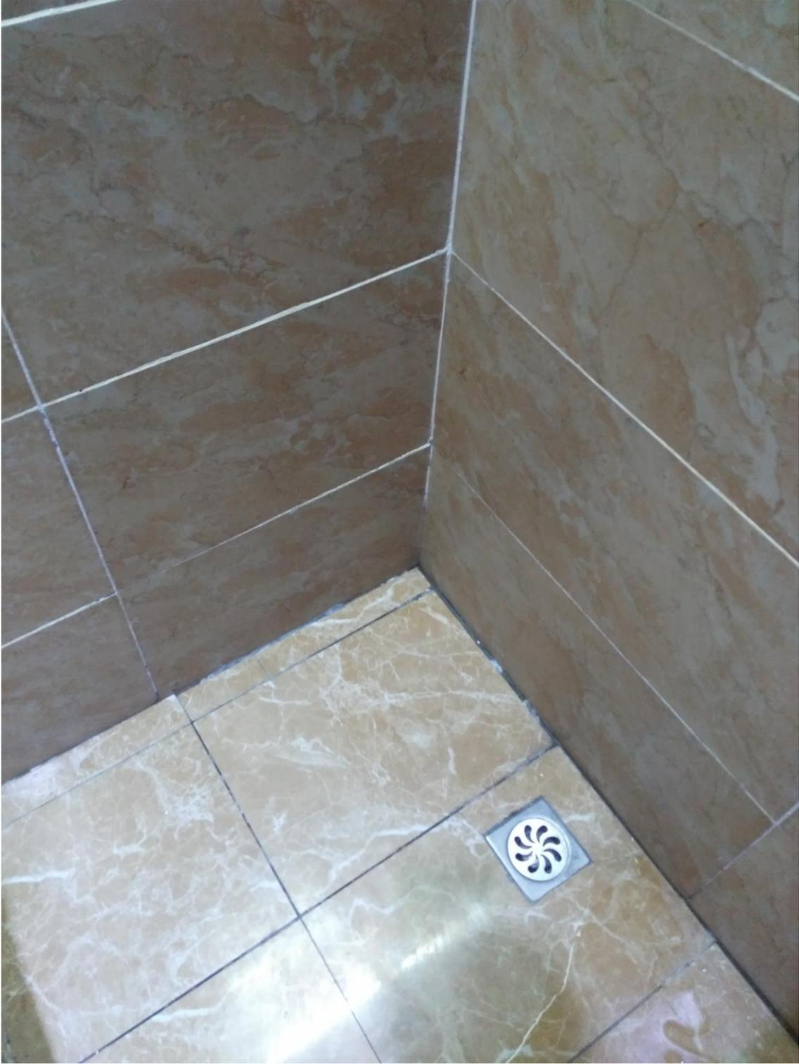
图 2 常见的中国浴室地板排水地漏，没有弯头
